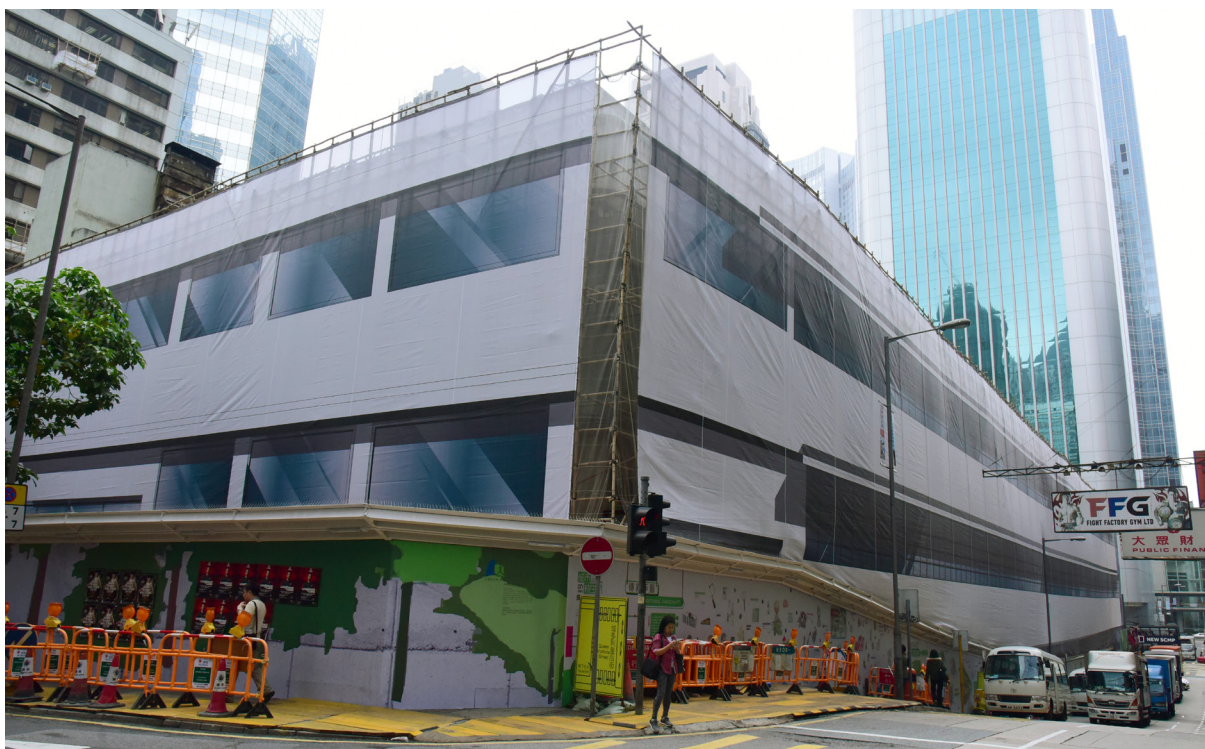
中環街市活化工程現已進入前期工程階段，工程主要於皇后大道中附近進行，日後將成為入口小廣場的休憩空間。
